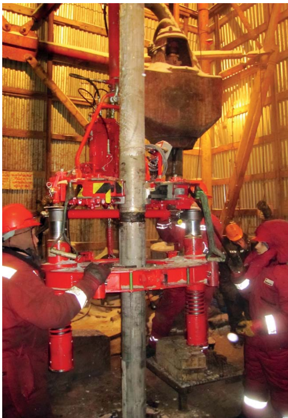
● Fig.3 A fragment of lowering the PS made of LOT 178x14 piping ● Рис.3 Фрагмент спуска ОК из труб ЛОТ 178x14
